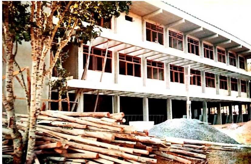
Figura 33 - Vista tramo 1 da obra
